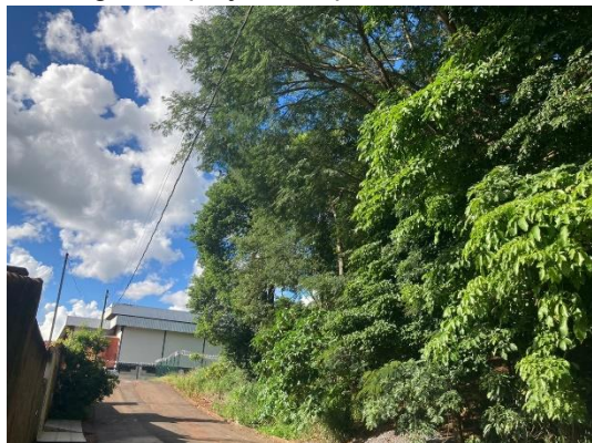
Figura 01: Imagem das espécies na reserva com galhos projetados para rede elétrica.
